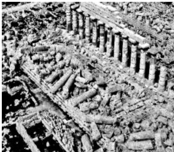
Fig. 5. Selinunte, tempio C, 1924. Veduta dopo l'anastilosi di 14 colonne e parte della relativa trabeazione, da parte dell'ing. Francesco Valenti. Le colonne furono integrate con muratura di mattoni, e ingrapate con elementi a coda di rondine; i rocchi lesionati furono consolidati con anelli di cemento armato. Quattro capitelli furono rinforzati con telai metallici; e gli architravi monolitici con ferri a doppia T, armati nella parte inferiore con tondini di ferro, integrati con calcestruzzo e camuffati con "impasto speciale ad imitazione del tufo antico". Grappe di bronzo invece furono utilizzate per il collegamento tra gli elementi del fregio (1964 - CICCD - Min. Beni Culturali ed Ambientali - Aerofototeca).
