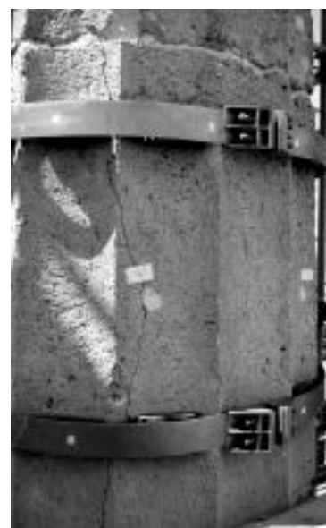
Fig. 8. Selinunte, tempio C. Collarizzazione della seconda colonna da est con fasce di acciaio inox (restauro effettuato nel 2000).
