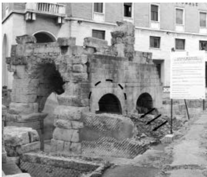
Fig. 1. Lecce, anfiteatro. Il restauro effettuato nel 2011 ha mantenuto la soluzione adottata nel restauro novecentesco, in cui è stata ripristinata la facciavista dell'alzato in blocchi là dove invece il rilievo evidenzia la presenza di una scala a salire, e quindi sarebbe stato più corretto riproporre almeno l'impronta della volta in opera cementizia.
