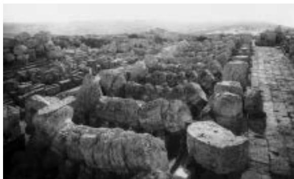
Fig. 4. Selinunte, tempio C, 1924. Colonne del lato nord della peristasi risistemate mantenendo la posizione di rinvenimento, in crollo da terremoto, poi rialzate nel 1925-26 insieme a parte della trabeazione pertinente (CICCD - Min. Beni Culturali ed Ambientali - Aerofototeca).
